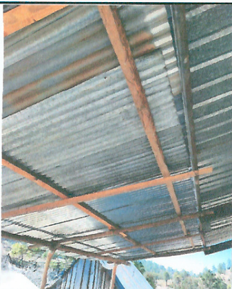
Foto 1: Estructura de techo
