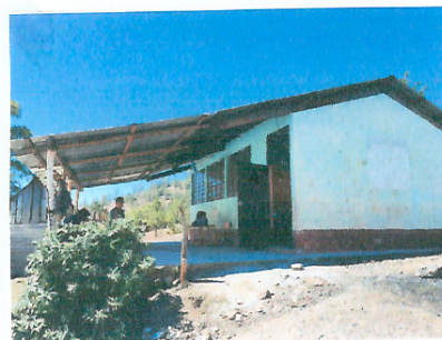
Foto 4: Cerca o muro perimetral
